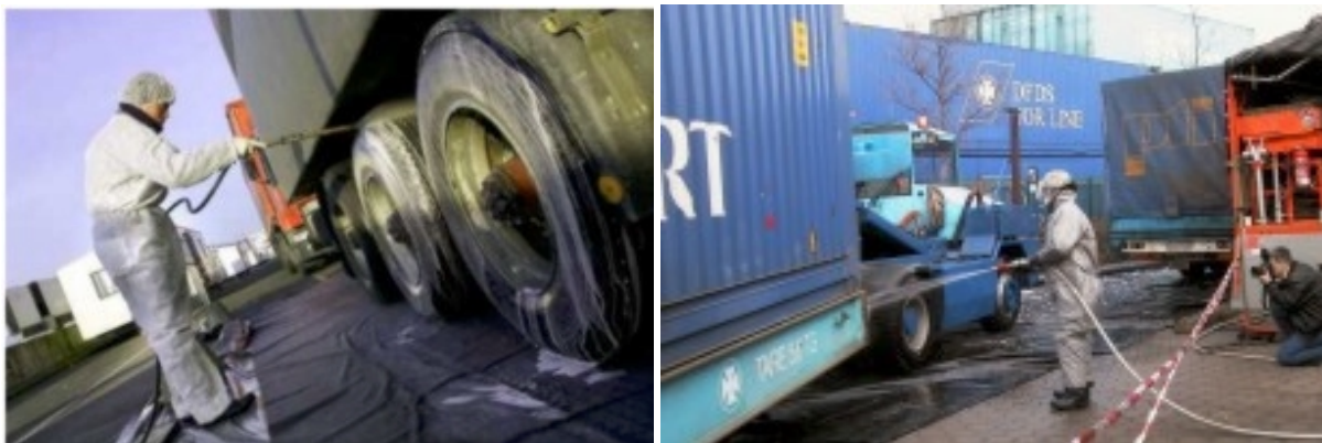
Abb. 1: Ganzflächige Fahrzeugdekontamination im mobilen Spühverfahren [3], [4]
