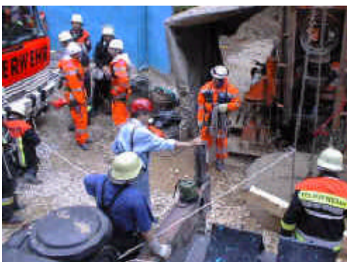
Einsatz der "HöRG - BF München" bei einem Tiefbauunfall (Brunnenbohrung) in Niederbayern
