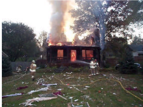
Durch eine Erdgasexplosion zerstörtes Haus
